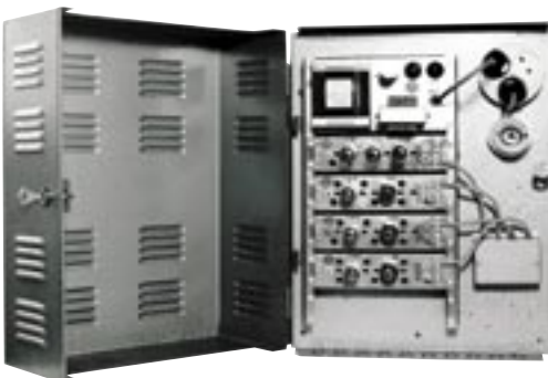
Antennivahvistin-keskus , jollaisia löytyi useimpien suomalaisten kerrostalojen kellarista tai ullakoilta.
