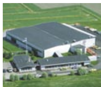
▲ Nousiaisten tehdas laajennuksen jälkeen, alkuperäinen kenkätehdas hallien edessä.
