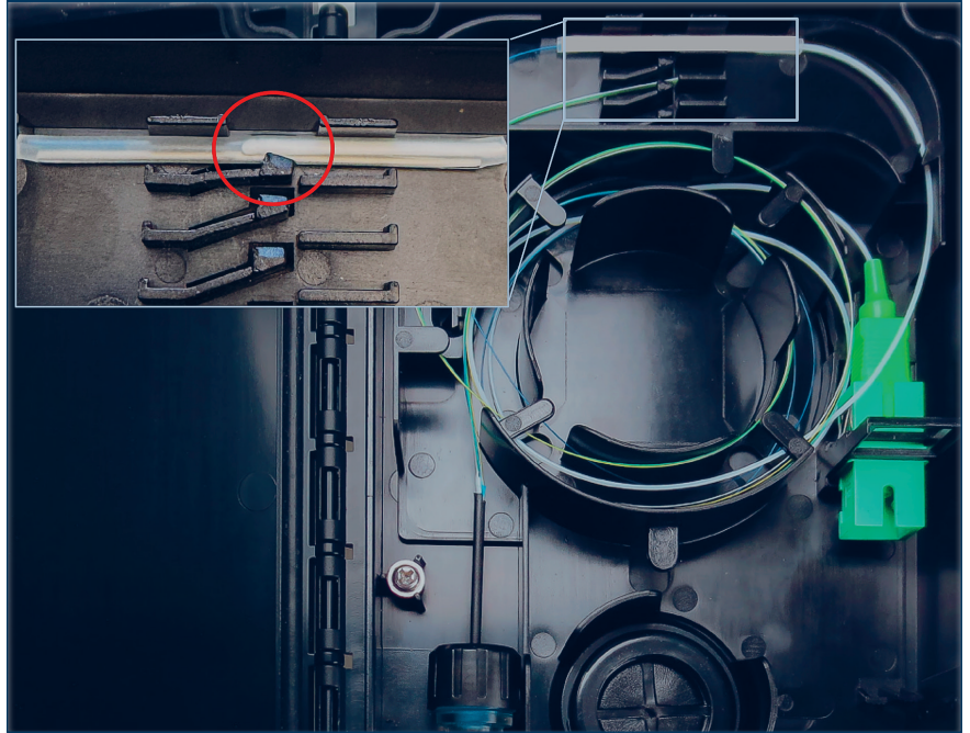
Kuitujatkossuojan asentaminen – hitsaussuojan metallipinni on asennettava alaspäin kohden kuvassa näkyvää kielekettä Kuva 6
